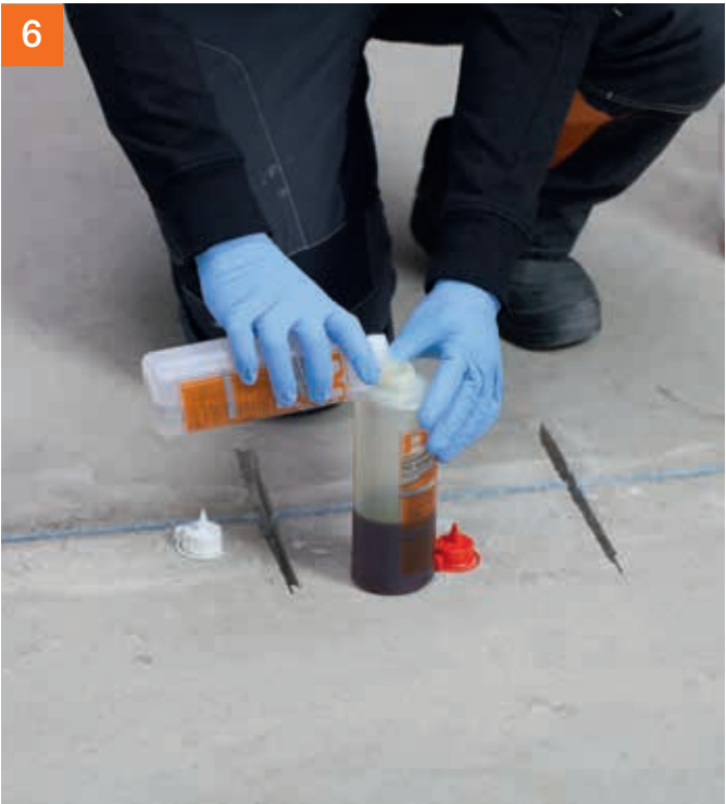
Sind die Nuten so weit vorbereitet, werden die beiden Komponenten von PCI Apogel® SH zusammengeschüttet ...
