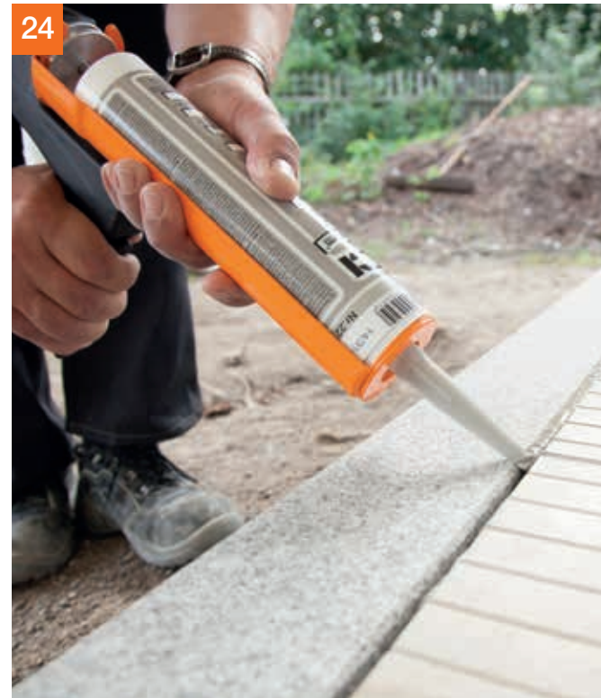
24 Silikonieren mit PCI Carraferm® im Übergang zum Naturwerkstein.
