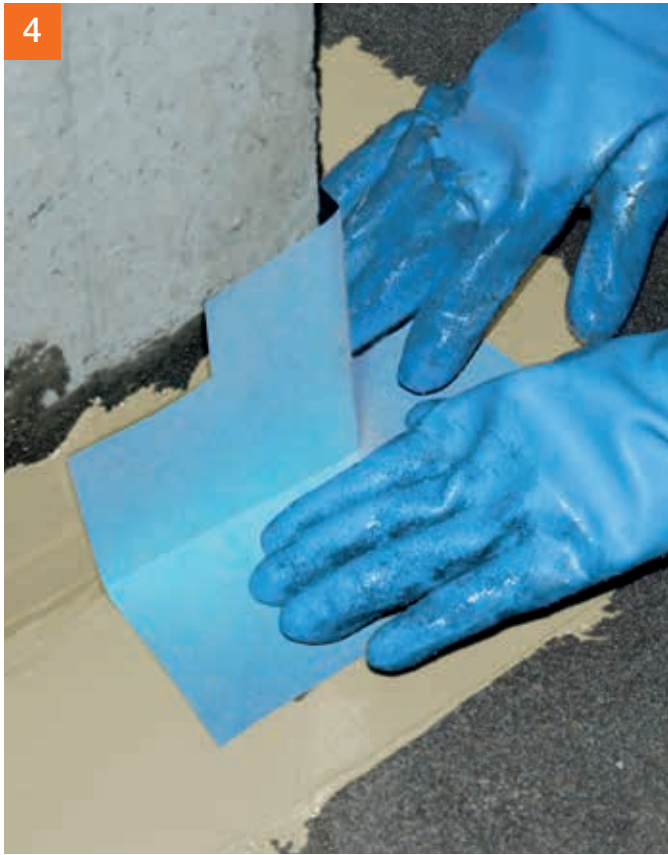
Formteil PCI Pecitape® 90° in die Abdichtungsschicht einlegen ...
