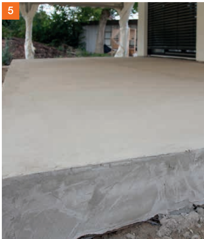
Terrassenplatte mit PCI Pericret® im Gefälle gespachtelt.
