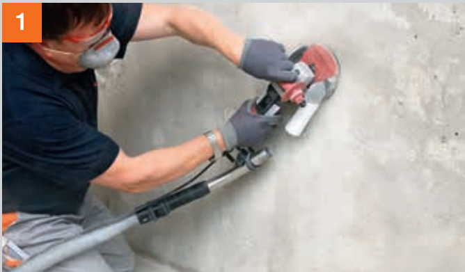
1 Grate und grobe Unebenheiten mittels Handfräse egalisieren.
