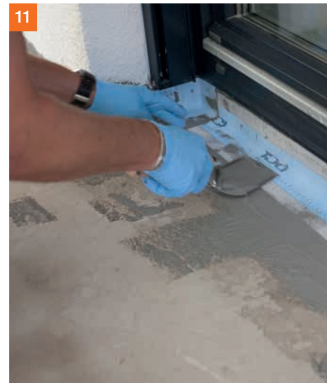
PCI Pecitape® 120 in PCI Seccoral® 2K Rapid einlegen.
