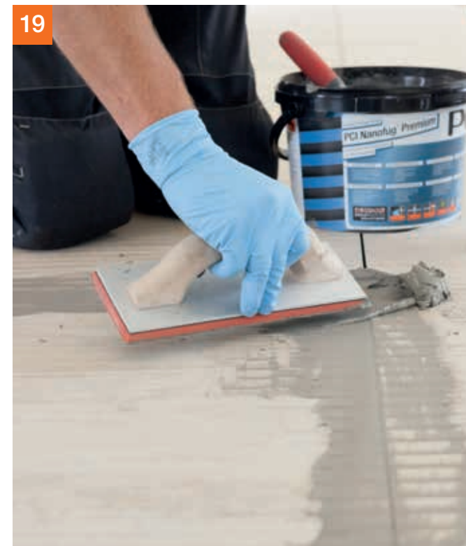
Fliesenbelag mit PCI Nanofug® Premium einfügen ...
