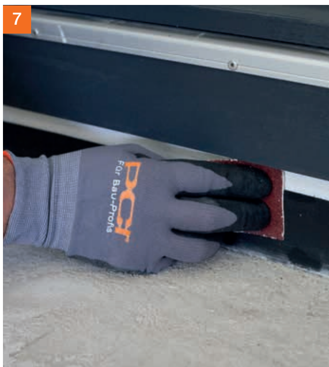
Detail Türabdichtung mit PCI Pecitape® 120: Element anschleifen und anschließend reinigen mit PCI Univerdünner.
