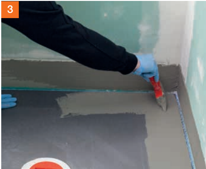
Danach wird PCI Seccoral® 1K / 2K Rapid auch im Bodenbereich vorgelegt.
