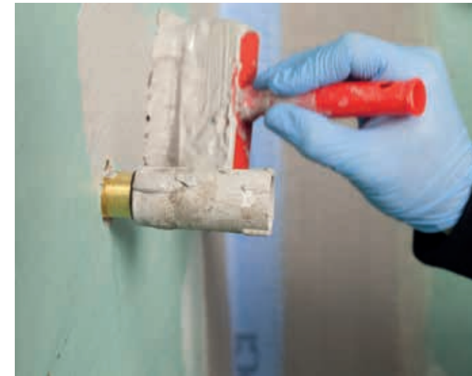
Abdichtensmaterial (PCI Seccoral® 1K/2K Rapid oder PCI Lastogum®) vorlegen...
