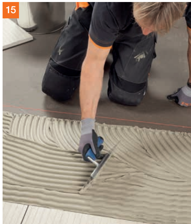
PCI Flexmörtel® Premium Kleberbett aufziehen.
