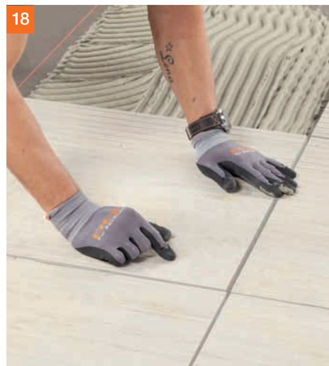
... einschieben und ggf. mittels Gummihammer einklopfen. Danach ausrichten.
