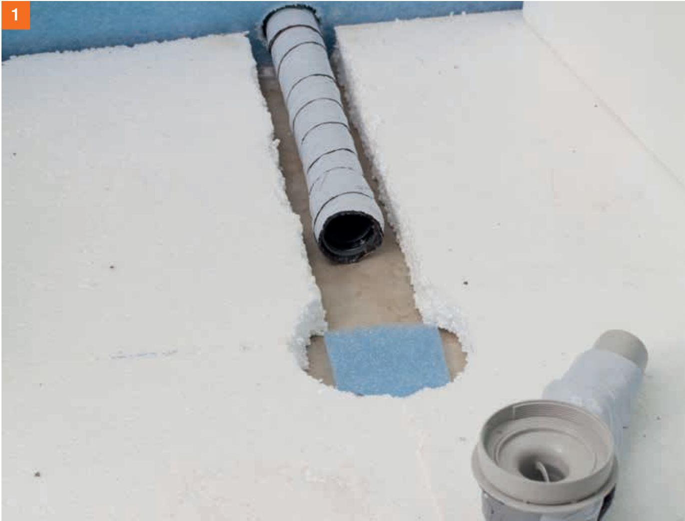
Der Einbau von PCI Pecibord® kann auf einer druckstabilen, vollflächig verklebten Polystyrol-Hartschaumplatte erfolgen.
