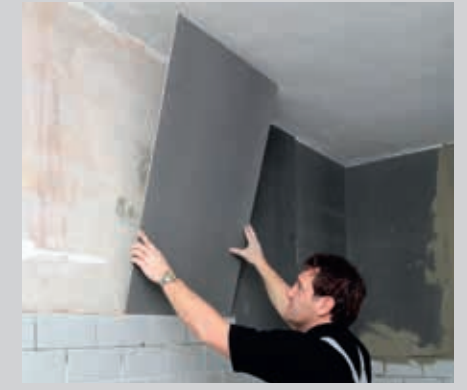
PCI PowerBoard-Element ansetzen und anschließend anklopfen.
