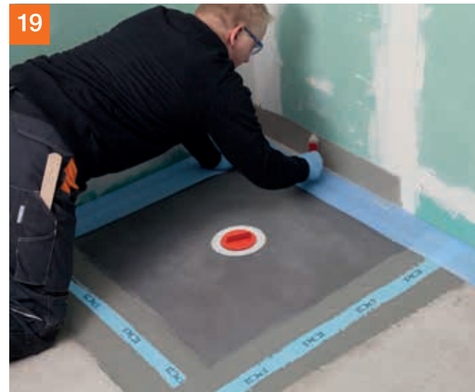
Nächster Schritt: Abdichten der Wand-/Bodenanschlüsse. Tipp: Zur Vermeidung von Schallbrücken vor der Applikation von PCI Seccoral® 1K / 2K Rapid an der Wand den Wand-/Bodenanschluss abdecken.
