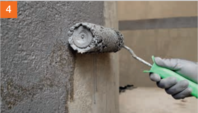
4 Tipp: Rollgrundierung mit verdünntem PCI Seccoral® 1K / 2K Rapid ausführen. Alle weiteren Arbeitsschritte finden Sie im Kapitel „Untergründe sicher abdichten“ ab Seite 40.
