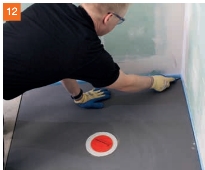
Den Randdämmstreifen bündig mit der Oberkante des PCI Pecibord® abschneiden.
