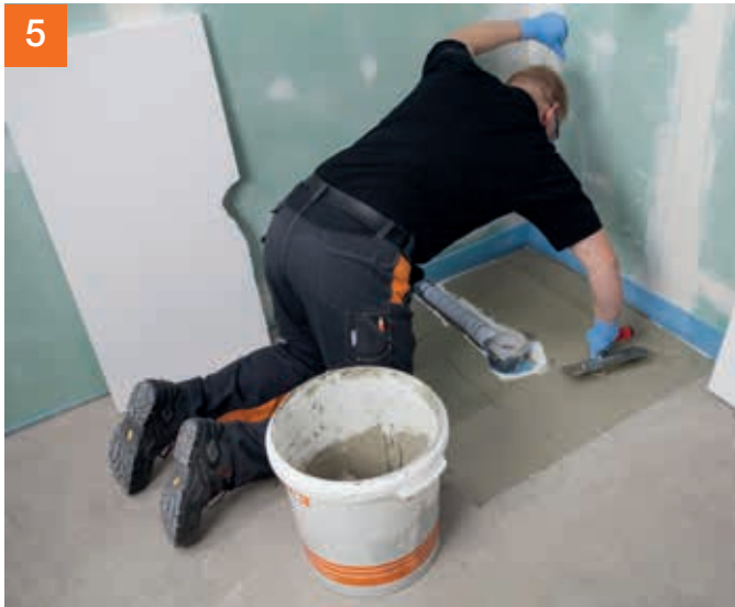
Die Höhenanpassung erfolgt mit Polystyrol-Hartschaumplatten in entsprechender Stärke.
