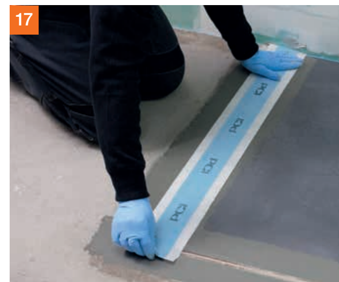
... PCI Pecitape® 120 einlegen, andrücken ...
