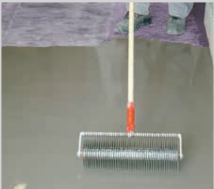
... und mit einer geeigneten Stachelwalze entlüften.
