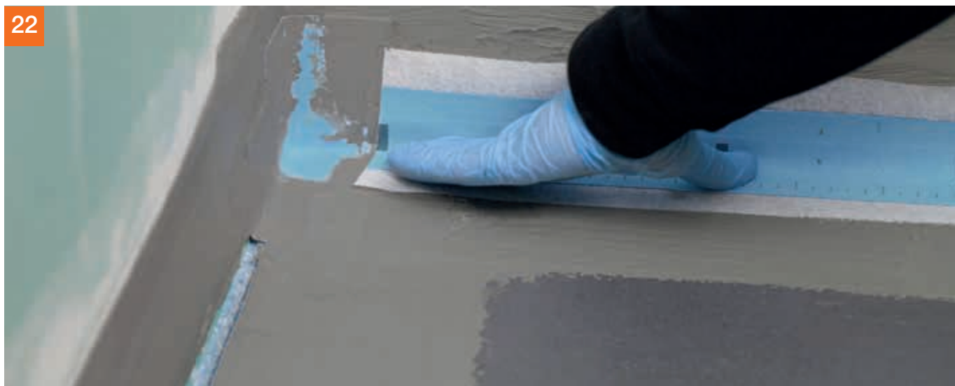
... dann PCI Pecitape® 120 einlegen, andrücken ...
