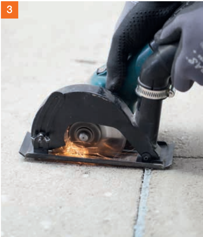
Anschließend werden diese Bereiche mittels Trennschleifer eingeschnitten ...
