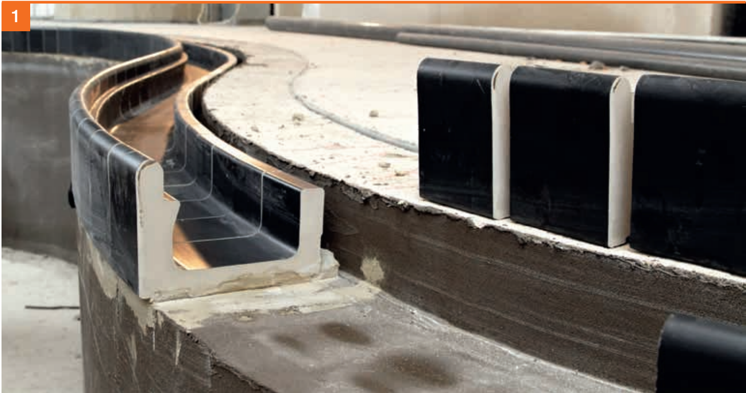
Rinnensteine zum Beispiel mit PCI FT® Klebemörtel + PCI Lastoflex® oder PCI Durapox® NT plus hohlraumfrei setzen. Der Epoxidharz-Kleber hat eine kapillarbrechende Wirkung und kann im Dünn- und Mittelbettverfahren eingesetzt werden. Bei Kleberstärken > 5 mm PCI Carrament® oder PCI FT® Ment verwenden.
