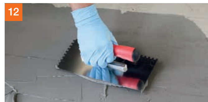
Kratzspachtelung mit PCI Seccoral® 2K Rapid ausführen.
