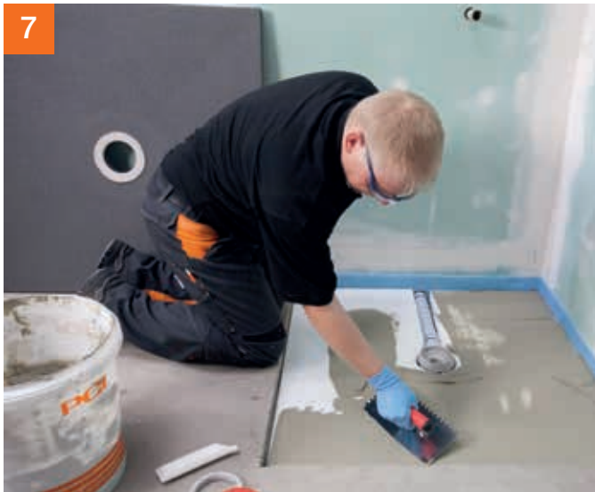
Fliesenkleber aufziehen, um das PCI Pecibord® mit dem Unterbauelement zu verkleben.
