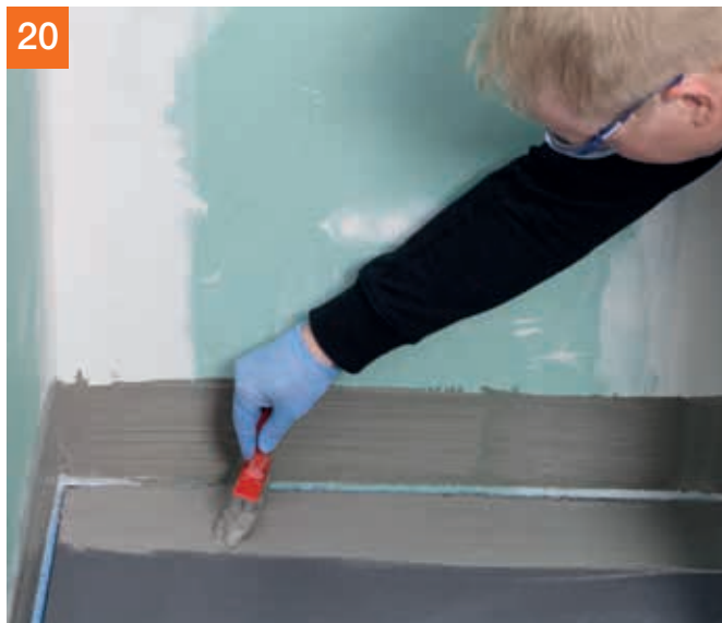
Abdeckung entfernen und im Randbereich PCI Seccoral® 1K / 2K Rapid vorlegen.
