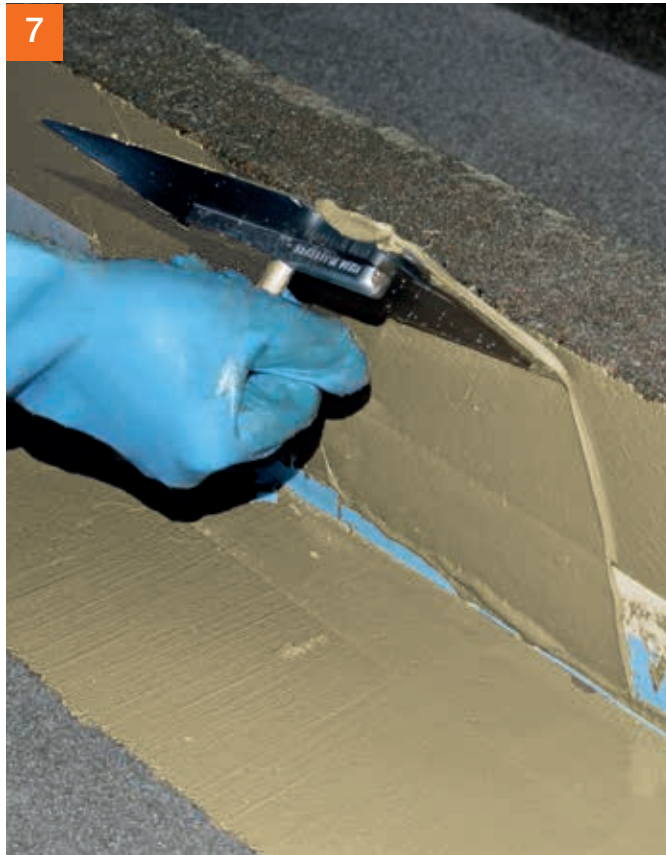
Anschließend noch einmal mit PCI Apoflex® überarbeiten.
