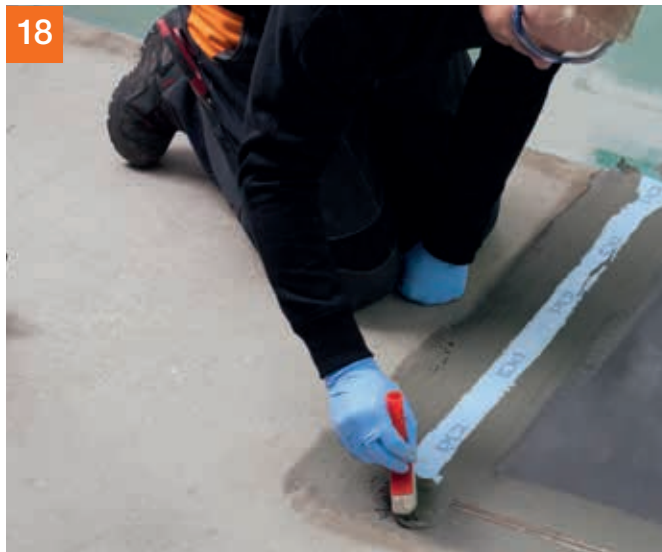
... und noch einmal an den Randbereichen mit PCI Seccoral® 1K / 2K Rapid überstreichen.
