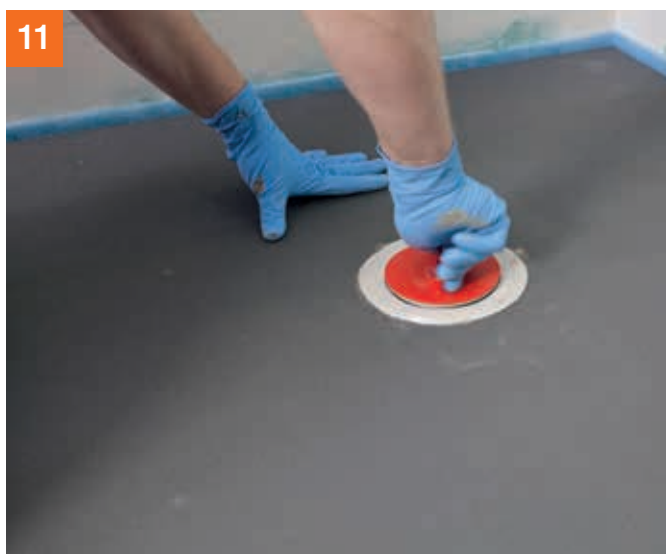
... anschließend das PCI Pecibord® mittels Baustopfen fest mit dem Bodenablauf verschrauben. Der Baustopfen stellt sicher, dass der Bodenablauf durch nachfolgende Arbeitsgänge nicht verunreinigt wird.
