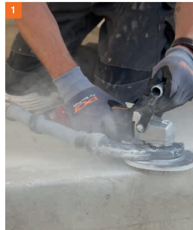
1 Untergrundvorbereitung: Grate entfernen.
