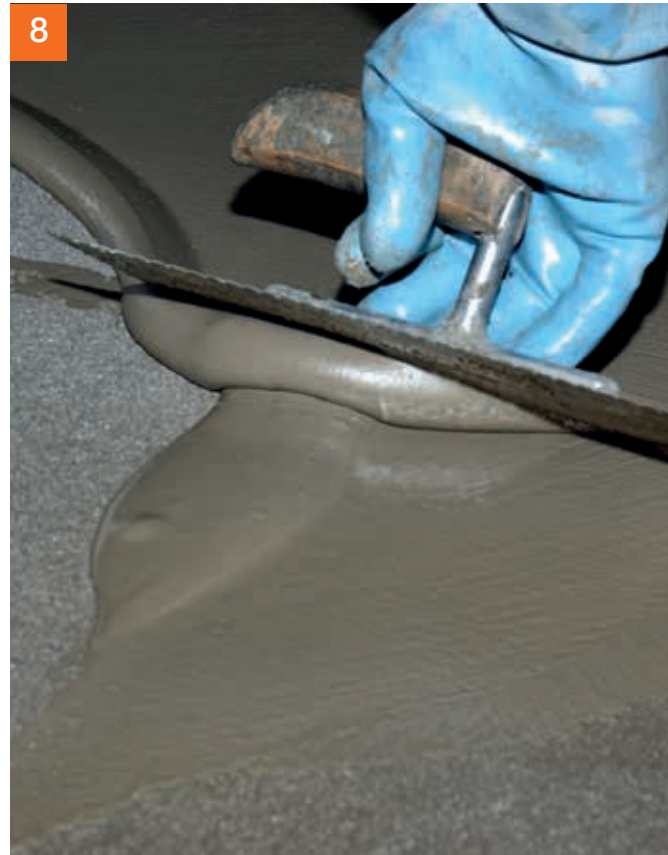
PCI Apoflex® in der Wand- oder Bodenvariante als Verbundabdichtung in zwei Arbeitsgängen auftragen.
