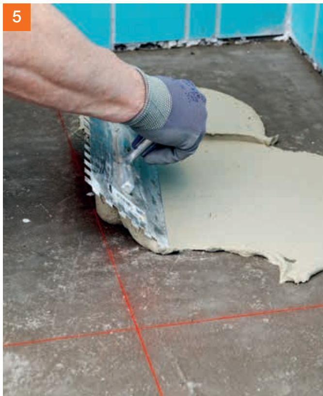
Auch bei der Verlegung der Bodenfliesen ...
