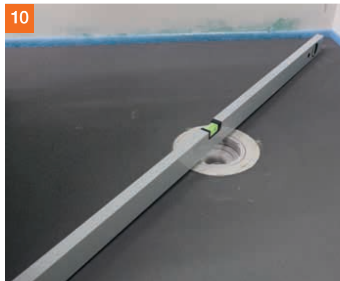
Korrekten Einbau mittels Wasserwaage prüfen und ...
