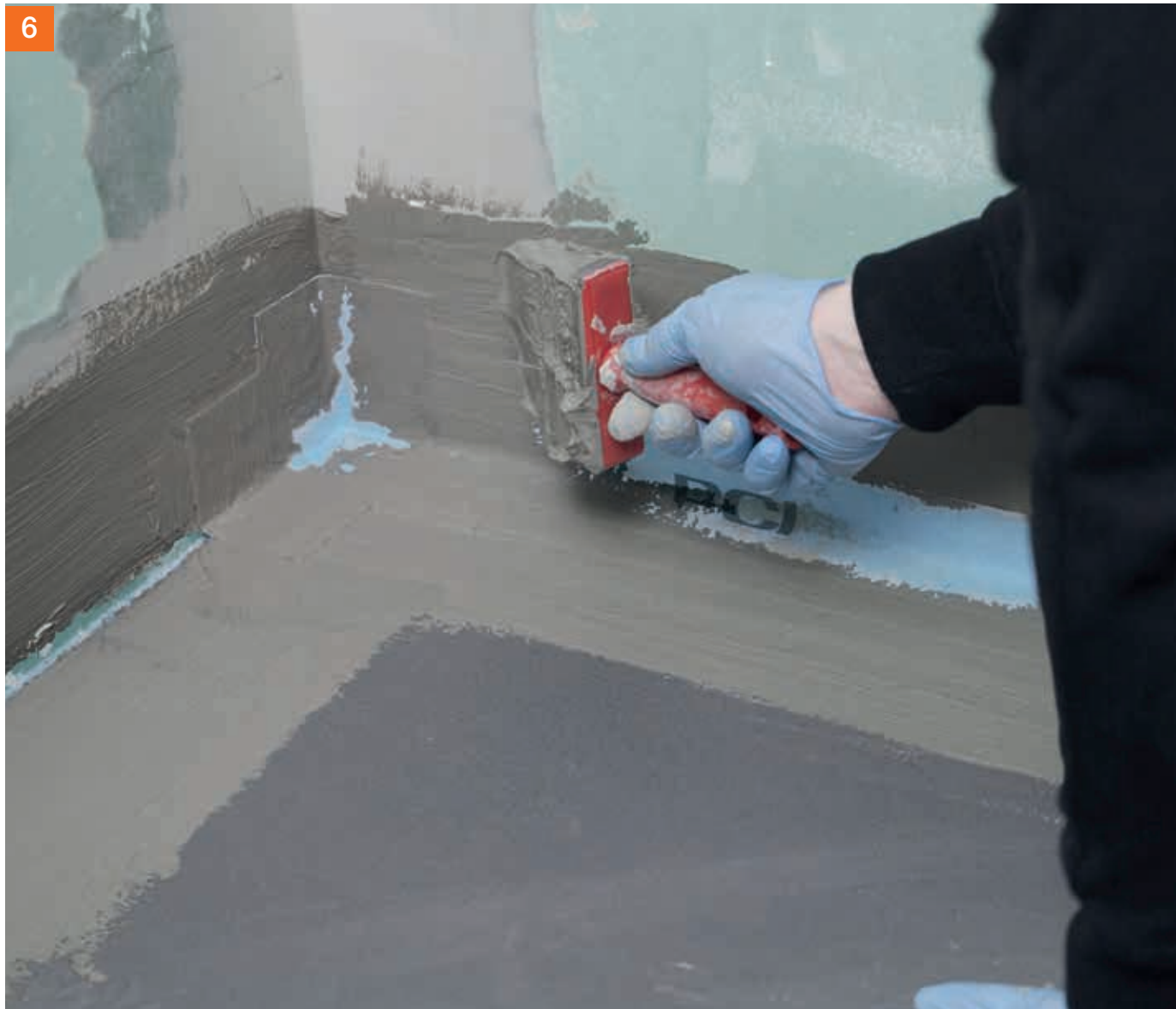
... und die vlieskaschierten Bereiche mit PCI Seccoral® 1K / 2K Rapid überstreichen.
