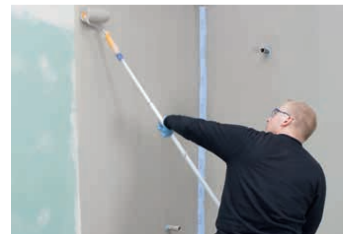
Flüssigabdichtungen sind immer mindestens 2-lagig auszuführen.
