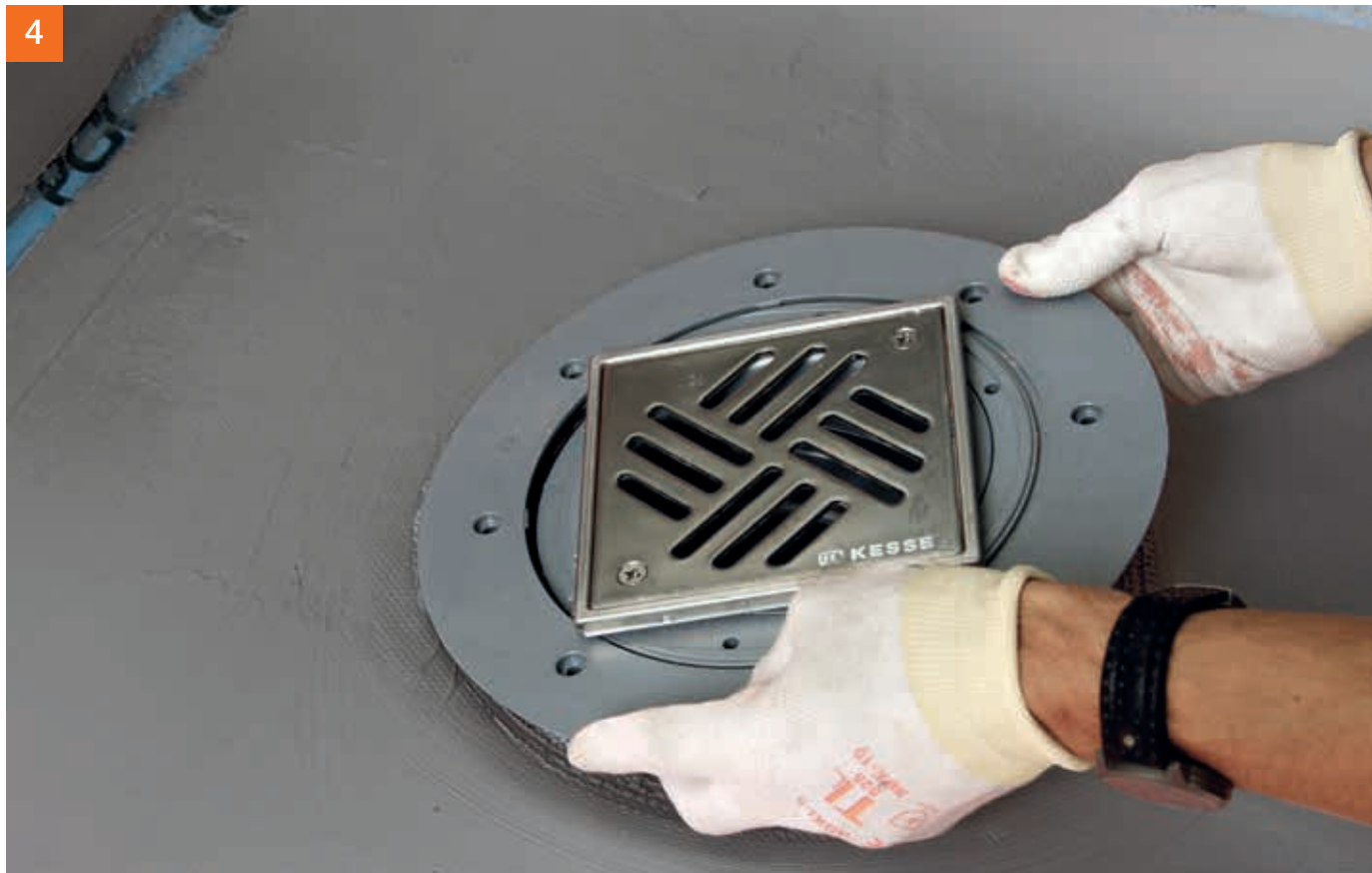
Klemmflansch aufsetzen und festschrauben.
