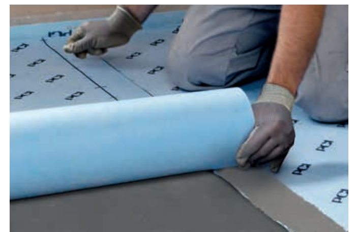
Die Stöße der Bahnen müssen ca. 5 bis 10 cm überlappen. Die Überlappung der Bahnen mit PCI Seccoral® 1K / 2K Rapid einstreichen und innerhalb der klebeoffenen Zeit die folgende Bahn eingelegt und sorgfältig angedrückt.
