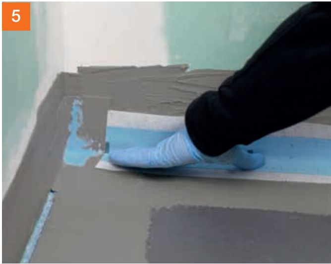
PCI Pecitape® 120 die Dichtcke überlappend einlegen ...
