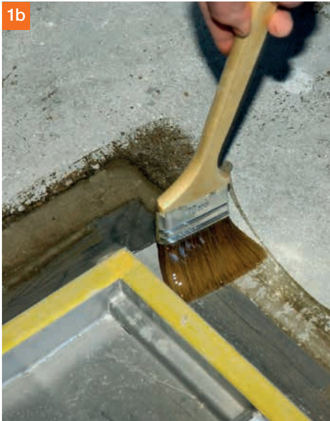
Details und Übergänge an Einbauteilen sowie Durchdringungen mit PCI Epoxigrund 390 grundieren.
