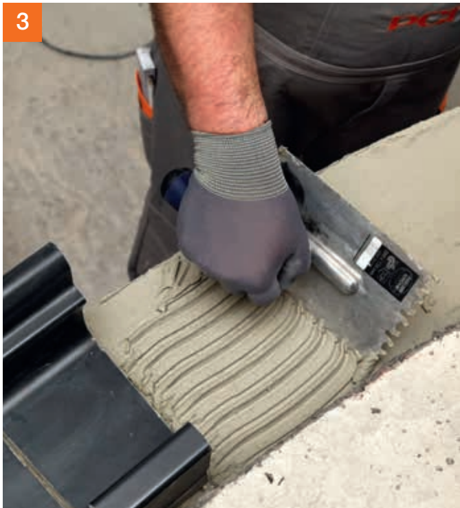
... und dann das Kleberbett aufkämmen.
