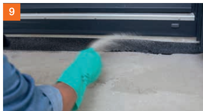
... anschließend die Grundierung absanden.
