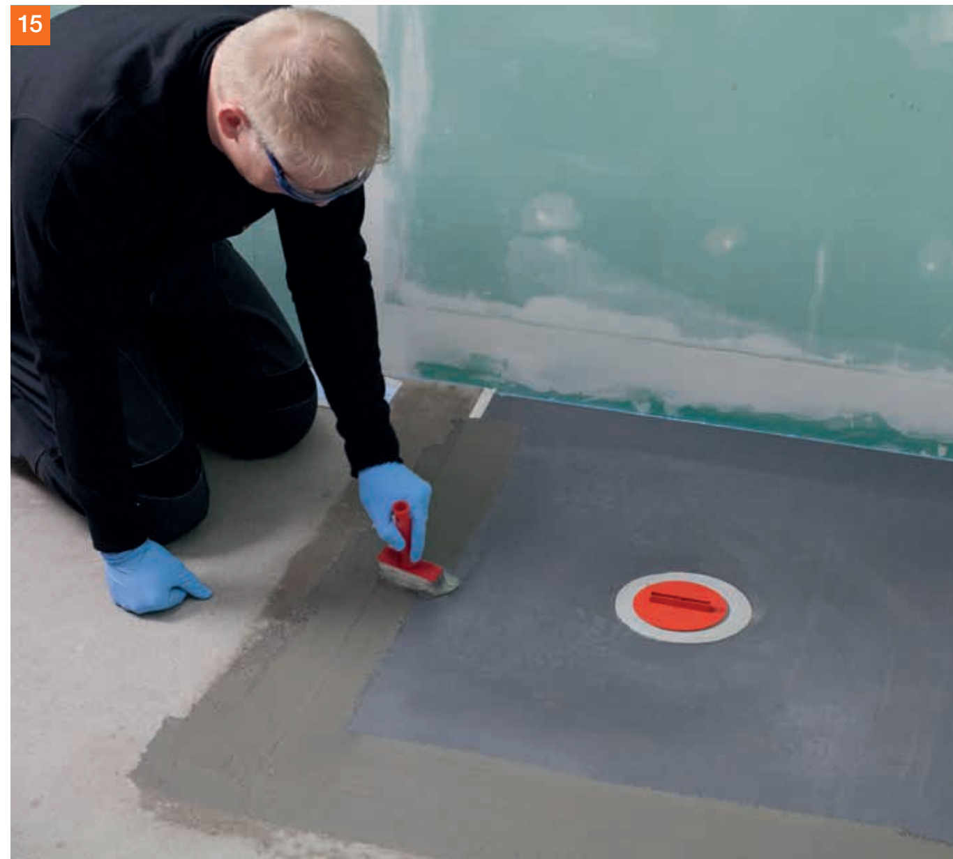
PCI Seccoral® 1K / 2K Rapid als Kleber für die Abdichtbänder vorlegen ...
