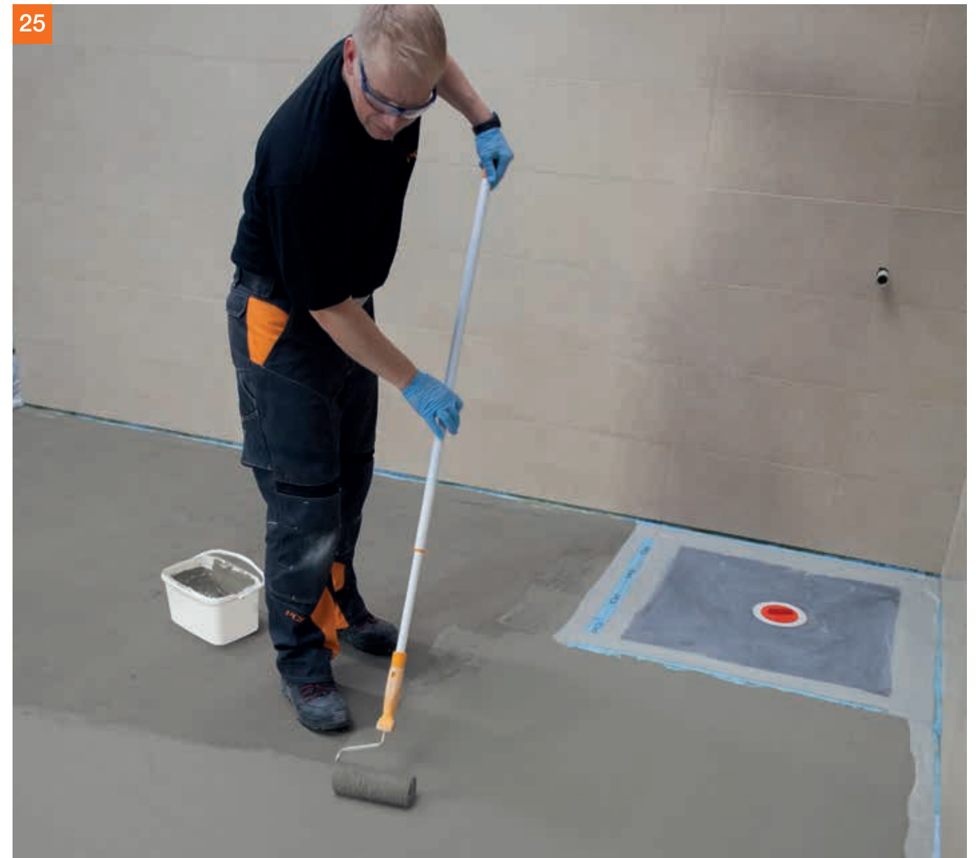
Nach ca. 1 Stunde erfolgt der jeweils nächste Auftrag mit PCI Seccoral® 1K / 2K Rapid bis zum Erlangen der Mindesttrockenschichtdicke von 2 mm.
