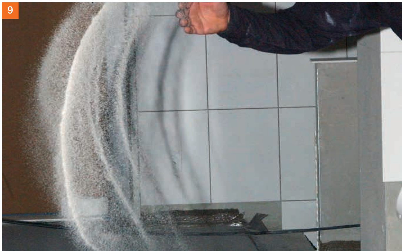
Zur besseren mechanischen Verkrallung mit dem Fliesenkleber PCI Apoflex® vollsatt mit Quarzsand abstreuen.
