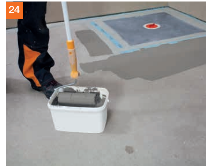
Anschließend Ausführen der Flächenabdichtung: 1. Auftrag mit PCI Seccoral® 1K / 2K Rapid.
