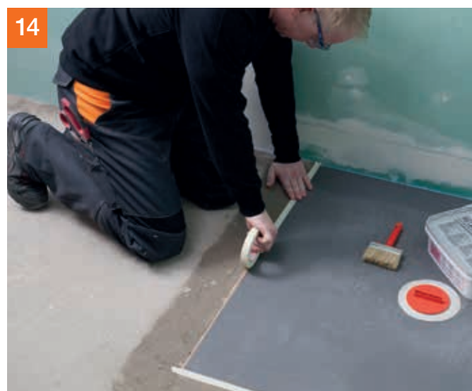
Tipp: Kleben Sie den schallentkoppelnden Randdämmstreifen mit einem Klebeband ab. Dann kann dort nichts dazwischenlaufen.
