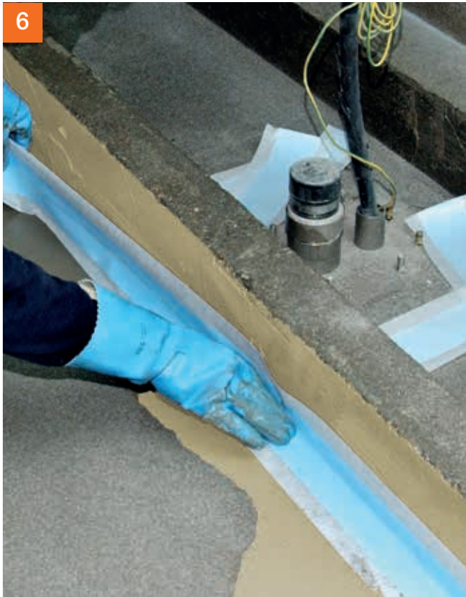
Danach wird zum Beispiel PCI Pecitape® 120 oder PCI Pecitape® Objekt eingelegt und übergearbeitet.
