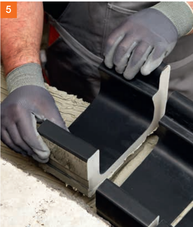
... Formteil frisch in frisch setzen ...
