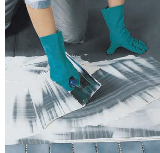
Mit dem verformungsfähigen Reaktionsharz-Fliesenkleber PCI Collastic® ...
