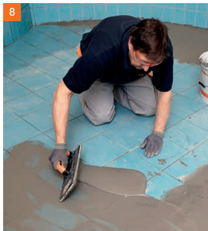
Am nächsten Tag erfolgt die Verfugung, zum Beispiel mit PCI Durafug® NT. Die Fläche einschlänmen ...
