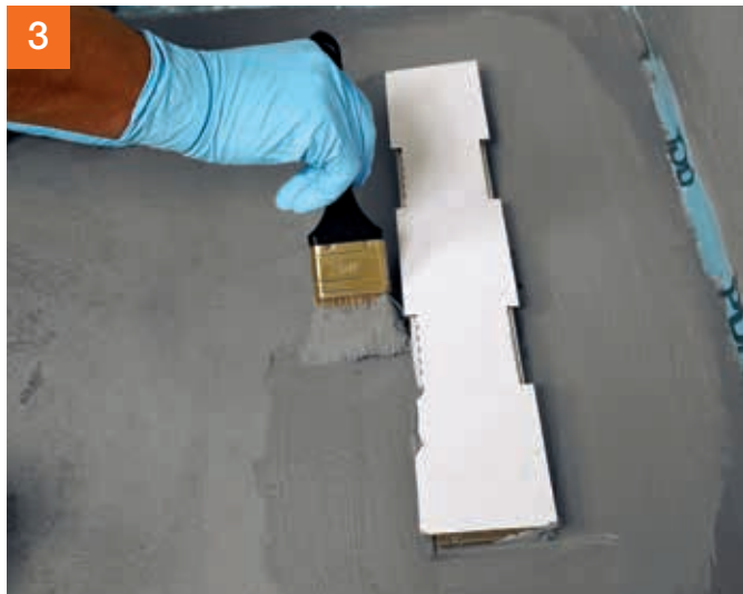
PCI Seccoral® 1K / 2K Rapid als Kleber für das werksseitig mitgelieferte Gewebe vorlegen ...
