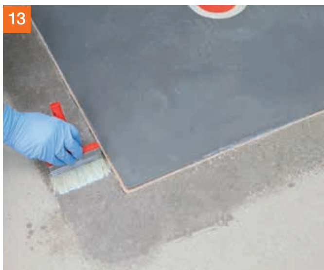
Estrich im Übergangsbereich mit Wasser vornässen.
