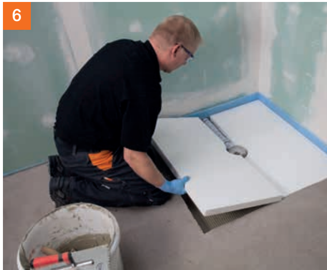
Die Platten werden untereinander mit einem Klebemörtel, zum Beispiel PCI Flexmörtel® S1, verklebt. Tipp: Höhe der Estrich-Konstruktion – Randstärke PCI Pecibord® – 5 mm für Fliesenkleber = Stärke der EPS-Platten
