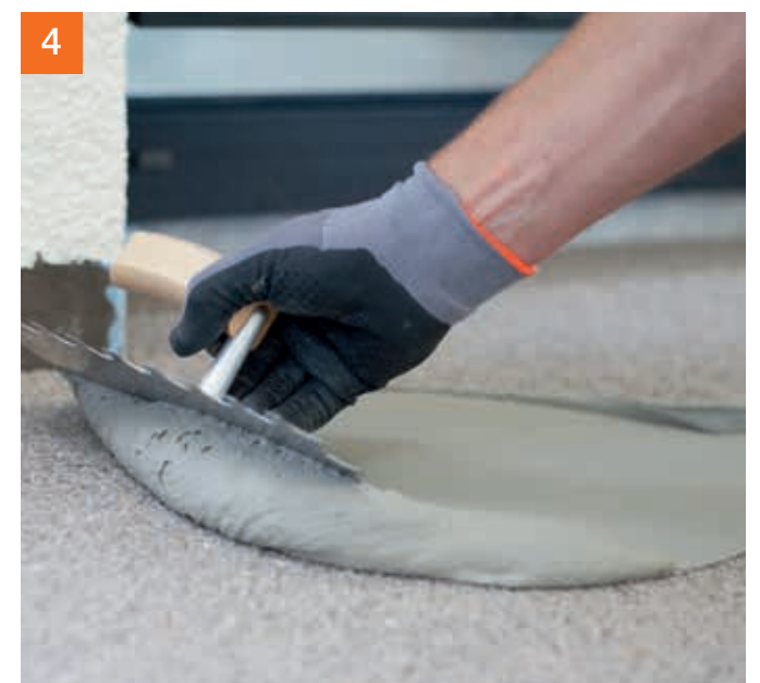
4 PCI Flexmörtel® Premium vorlegen und als Kratzspachtelung ausführen.
