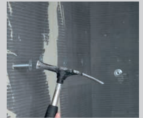
Zu guter Letzt die Schlagdübel einschlagen.
