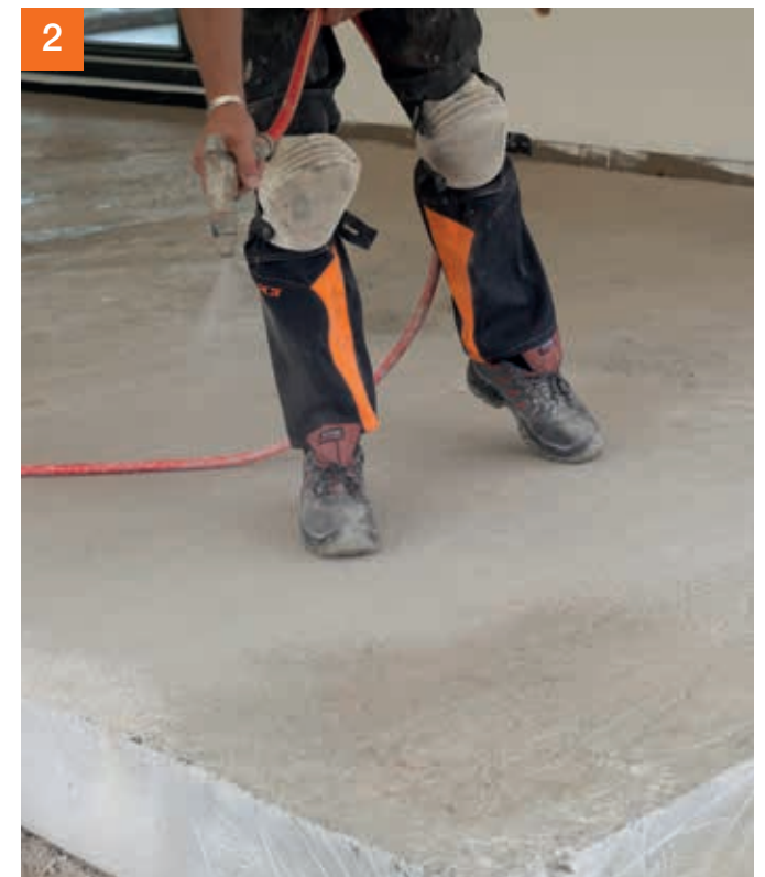
2 Untergrund vornässen für die Aufbringung der Ausgleichspachtelung.
