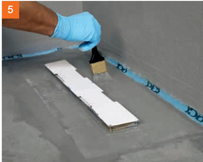
... und mit etwas Abdichtungsmaterial nochmals überstreichen.
