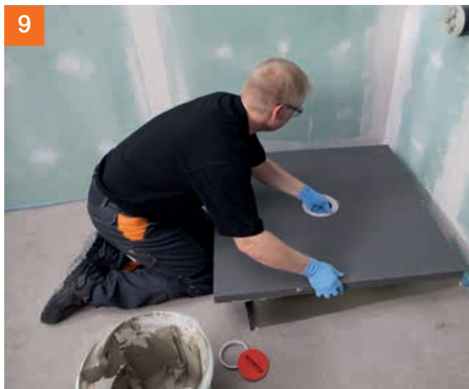
... und das PCI Pecibord® ansetzen und andrücken, bis der Dichtungsring den Rand des Bodenablaufs sauber umschließt.
