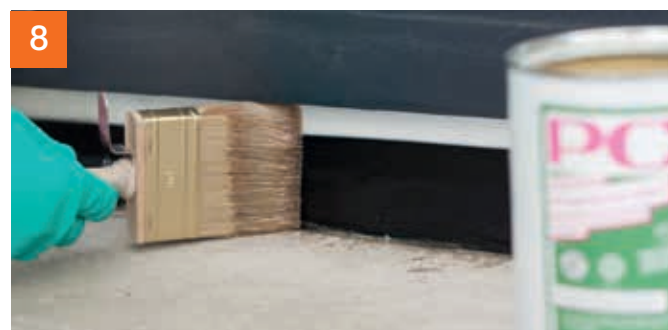
Element grundieren mit PCI Epoxigrund 390 ...
