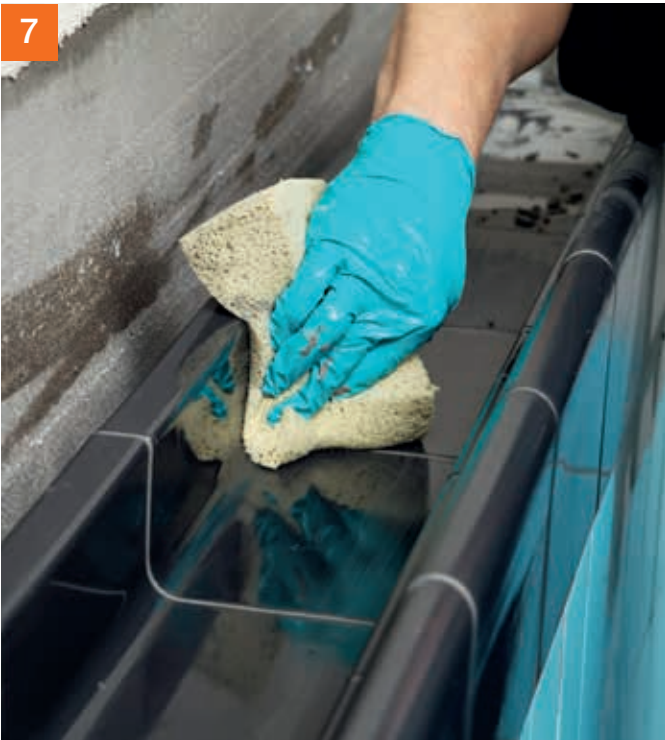
Sind die Rinnensteine gesetzt, kann nachfolgend zum Beispiel mit PCI Durafug® NT oder PCI Durapox® NT plus verfugt werden.
