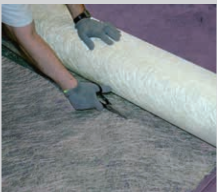
Das Glasfasergelege der PCI Armiermatte GFM mit einer Schere zurechtschneiden und auf dem grundierten Untergrund auslegen bzw. ausrollen.
