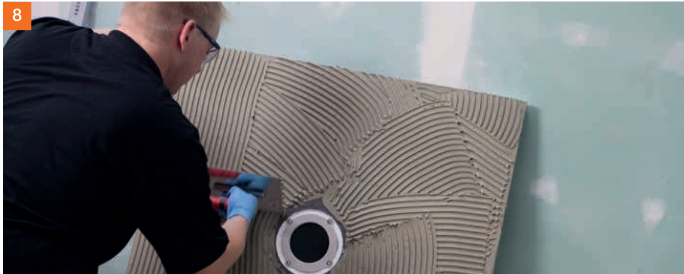
Zunächst eine Kratzspachtelung auf dem Unterbau und der Rückseite des PCI Pecibord® ausführen, den Kleber aufkämmen ...
