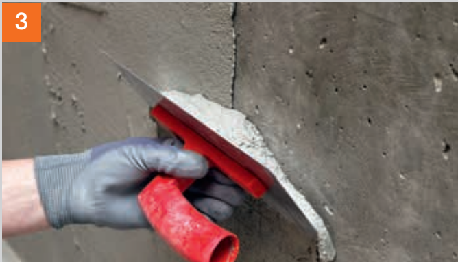
3 Fläche mit PCI Pericret® egalisieren.
