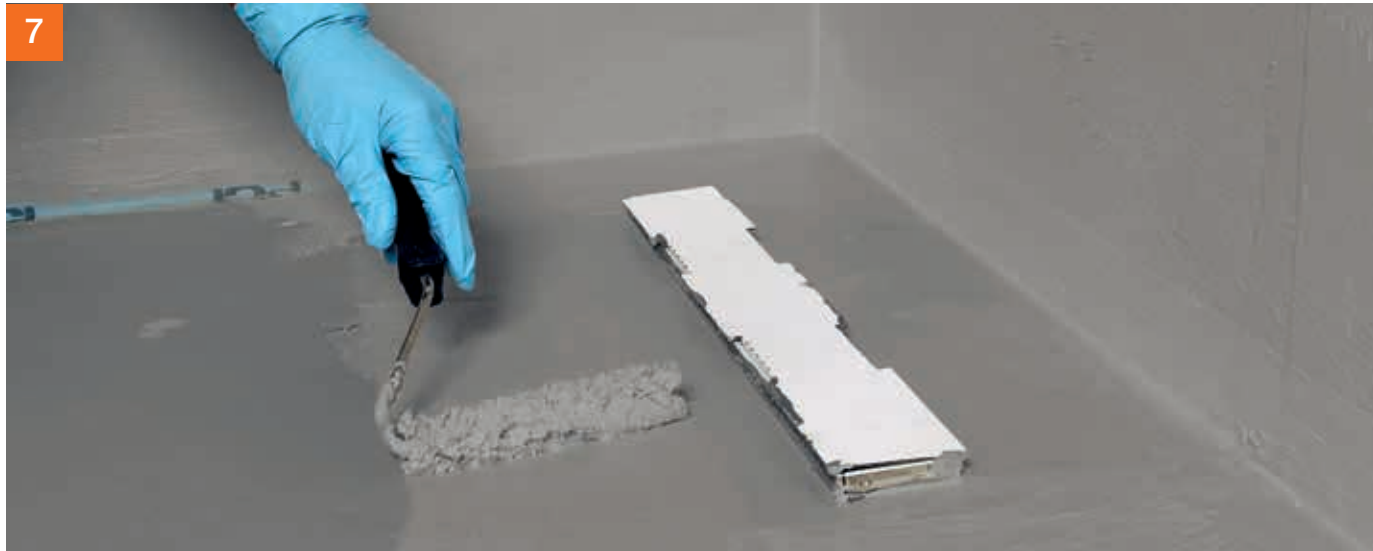
Nach einer Wartezeit von ca. 1 Stunde erfolgt jeweils nächste Auflag bis zum Erlangen der Mindesttrockenschichtdicke von 2 mm.
