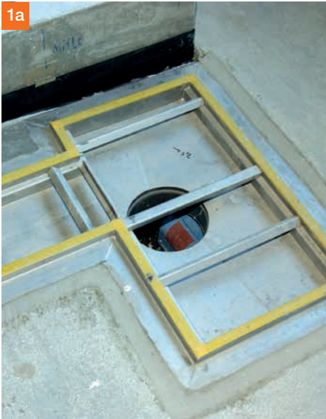
Einbauteile, Abläufe, Durchdringungen, Rinnen und Schwallmulden werden in die Flächenabdichtung eingebunden.
