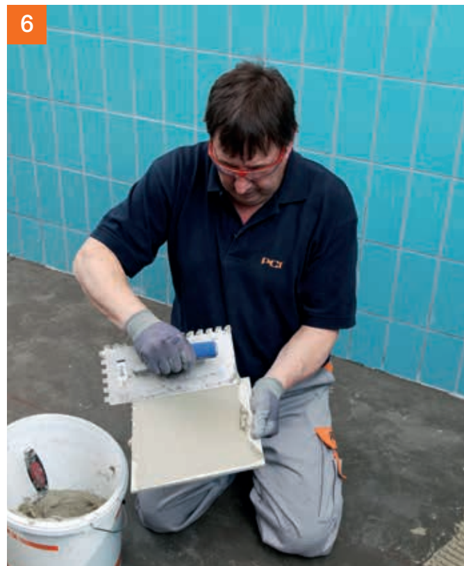
... wird das Buttering-Floating-Verfahren angewendet.
