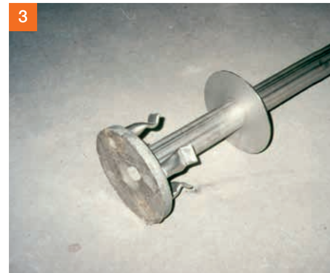
Durchdringung aus Edelstahl für Wasserzulauf.
