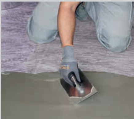
Mit einer Glättkelle verteilen (keine Rakel verwenden!) ...
