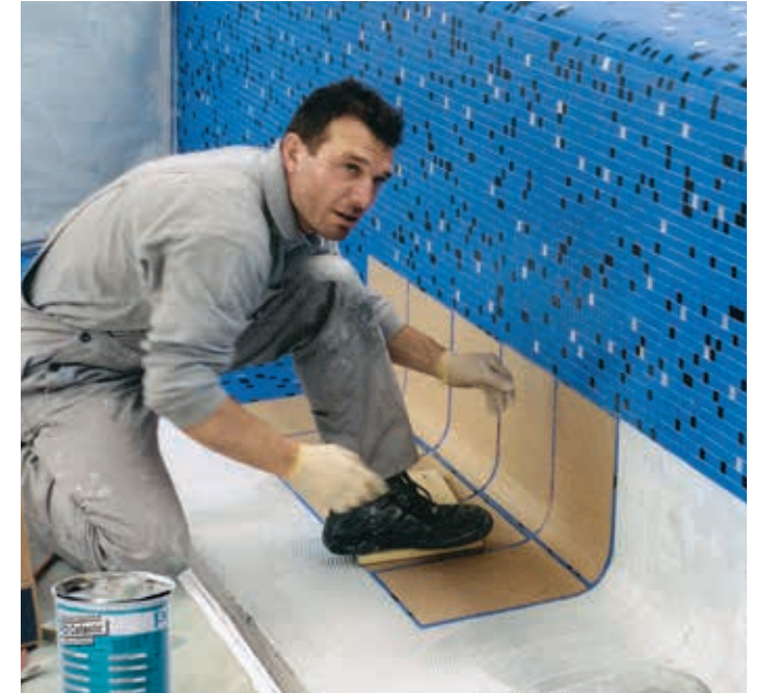
... werden keramische Beläge sicher auf Stahlkonstruktionen verlegt.
