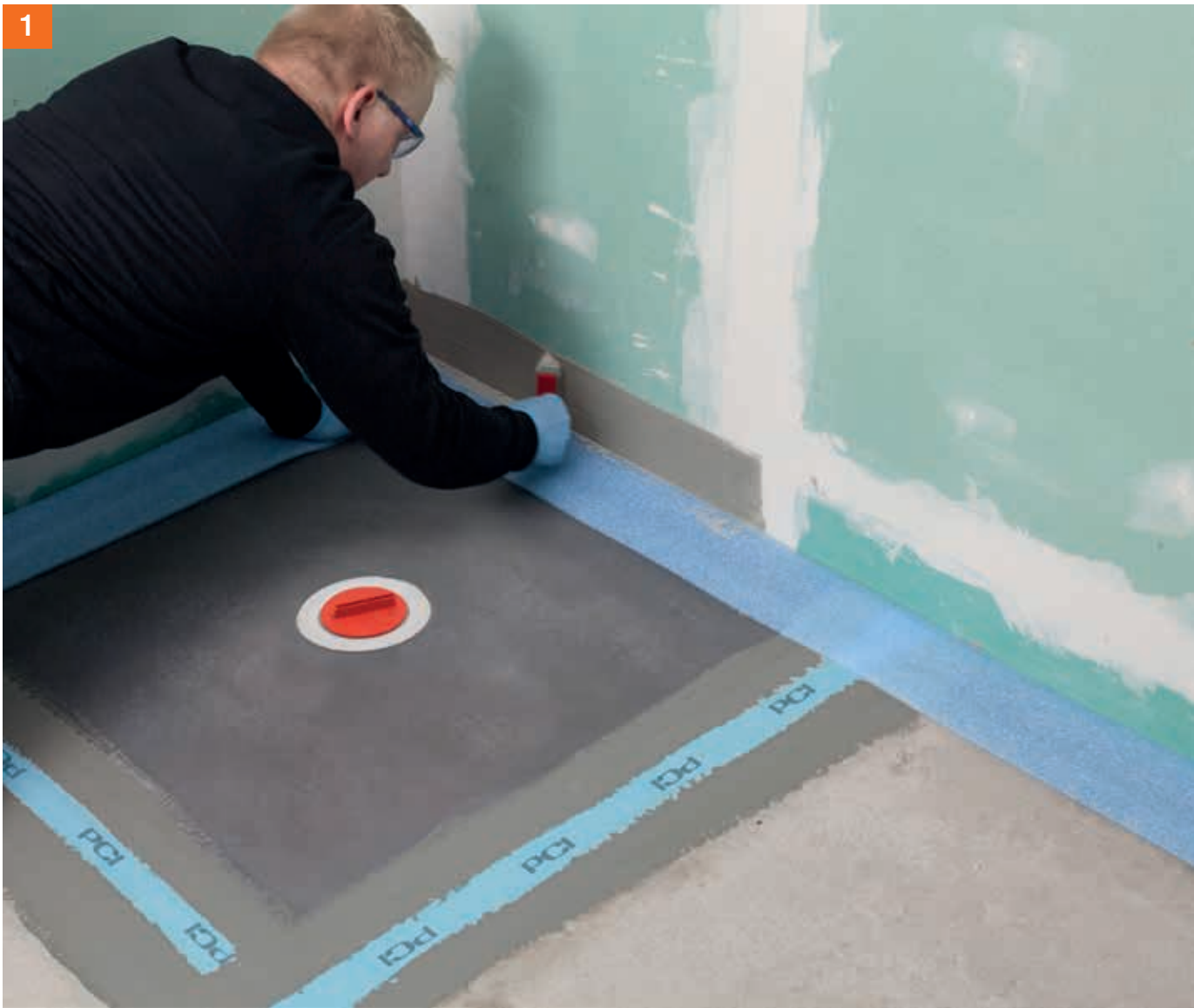
Um den Randdämmstreifen vor Kontakt mit dem Abdichtungsmaterial zu schützen, empfehlen wir diesen Bereich beim Arbeiten an der Wand sorgfältig abzudecken.
